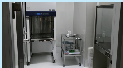
安全キャビネットを完備した外来ケモ対応の無菌室
